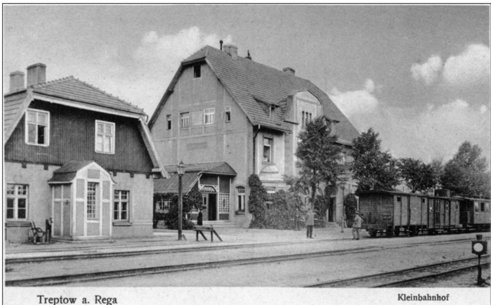
Abb. 12. Der Bahnhof Treptow an der Rega in den 1930er Jahren. Vorhanden waren ein kleines (links) und ein großes Bahnhofsgebäude (rechts). Foto Sammlung W.-D. Machel
